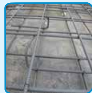
شکل ۳-۵۵- استفاده از خرک در میلگرد گذاری دال
