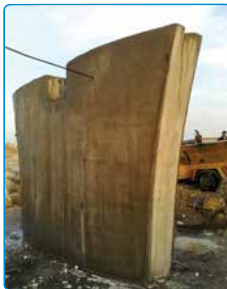
شکل ۳-۴۲- قالب برداری
