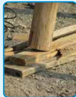
شکل ۲۵-۳- استفاده از گوه جهت تنظیم ارتفاع
