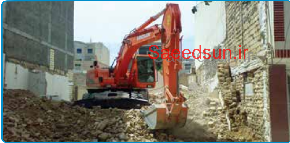
شکل ۳-۲- خاکبرداری با ماشین
