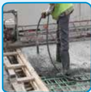
شکل ۱۴-۳- ویبراتور یا لرزاننده بتن داخل قالب
