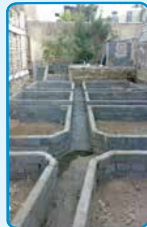
شکل ۳-۳۰- اجرای قالب پی با استفاده از بلوک بتنی
