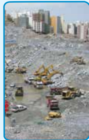
شکل ۳-۷- گودبرداری در زمین‌های نامحدود
