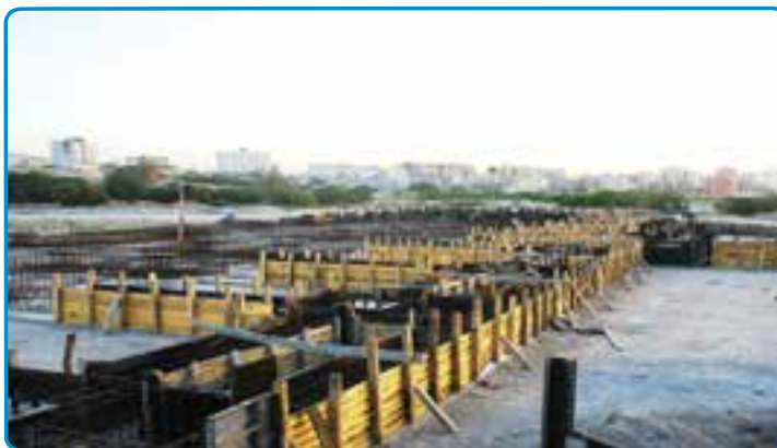
شکل ۳-۲۷-۳- قالب چوبی برای اجرای پی
