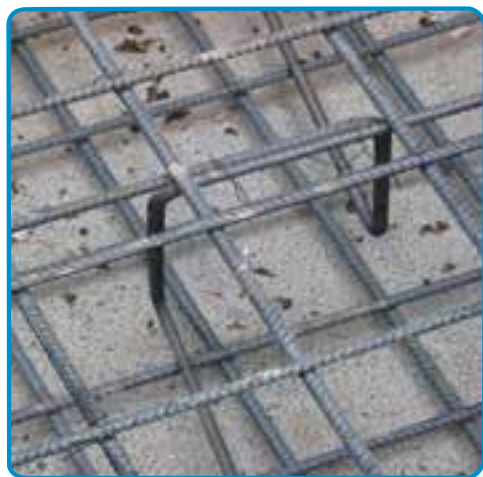
شکل ۳-۵۳- استفاده از خرک در میلگرد گذاری پی
