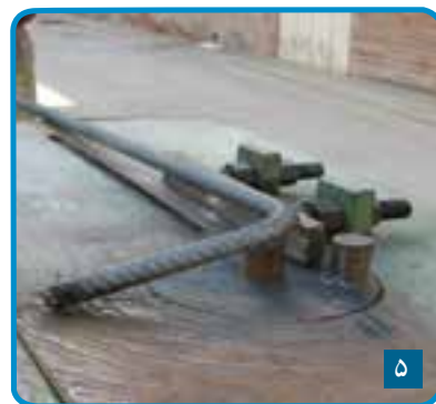
شکل ۳-۶۴- خم کردن میلگرد
