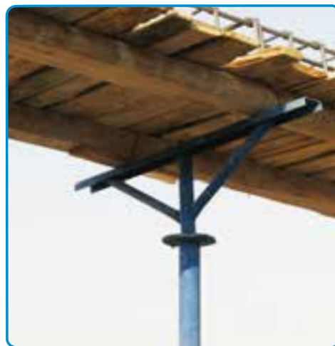
شکل ۲۱-۳- استفاده از شمع‌های فلزی جهت نگهداری قالب‌ها
