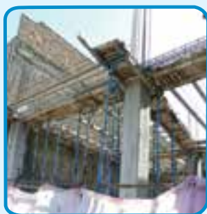
شکل ۳-۳۹- استفاده از قالب چوبی برای اجرای تیر
