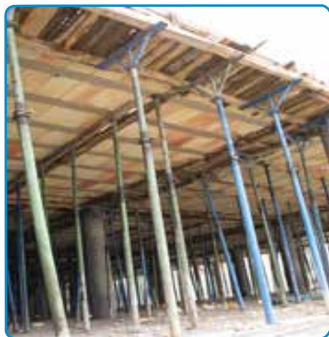
شکل ۲۱-۳- استفاده از شمع‌های فلزی جهت نگهداری قالب‌ها
