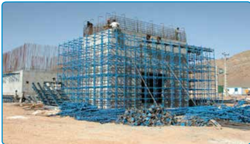
شکل ۳-۲۶-۳- داربست فلزی
