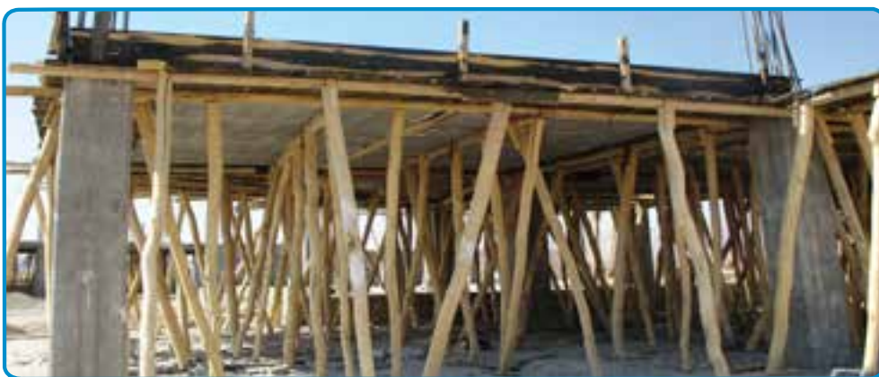
شکل ۲۴-۳- استفاده از شمع‌های چوبی جهت نگهداری قالب‌ها
