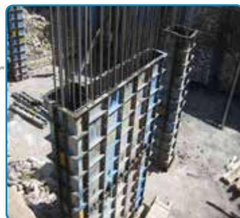
شکل ۳-۳۵- قالب فلزی برای اجرای دیوار بتنی
