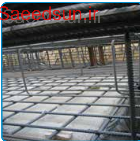
شکل ۳-۵۳- استفاده از خرک در میلگرد گذاری پی
