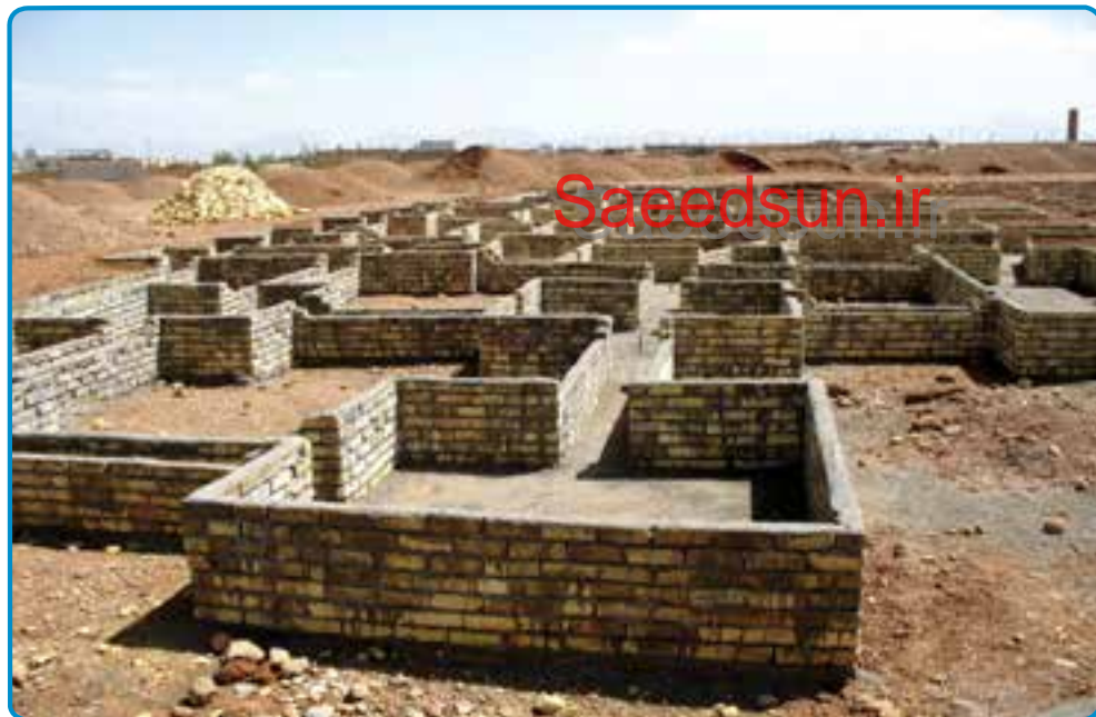
شکل ۱۵-۳- استفاده از قالب آجری برای اجرای پی
