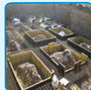
شکل ۳-۳۱- قالب فایبرگلاس برای اجرای پی
