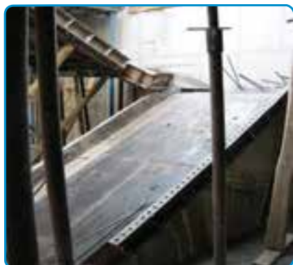
شکل ۳-۴۰- استفاده از قالب فلزی برای اجرای پله بتنی
