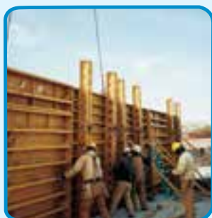
شکل ۳-۳۶- قالب فایبر گلاس برای اجرای دیوار بتنی
