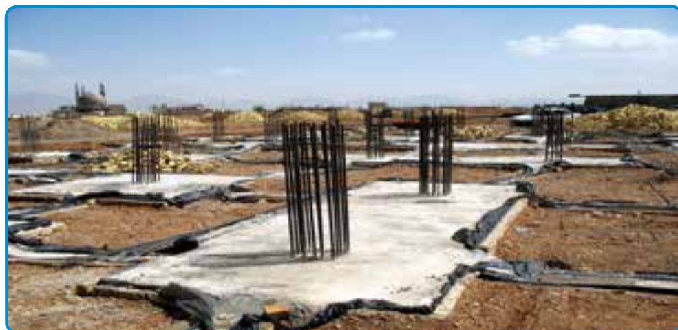
شکل ۱۰-۳- استفاده از پلاستیک در پی
