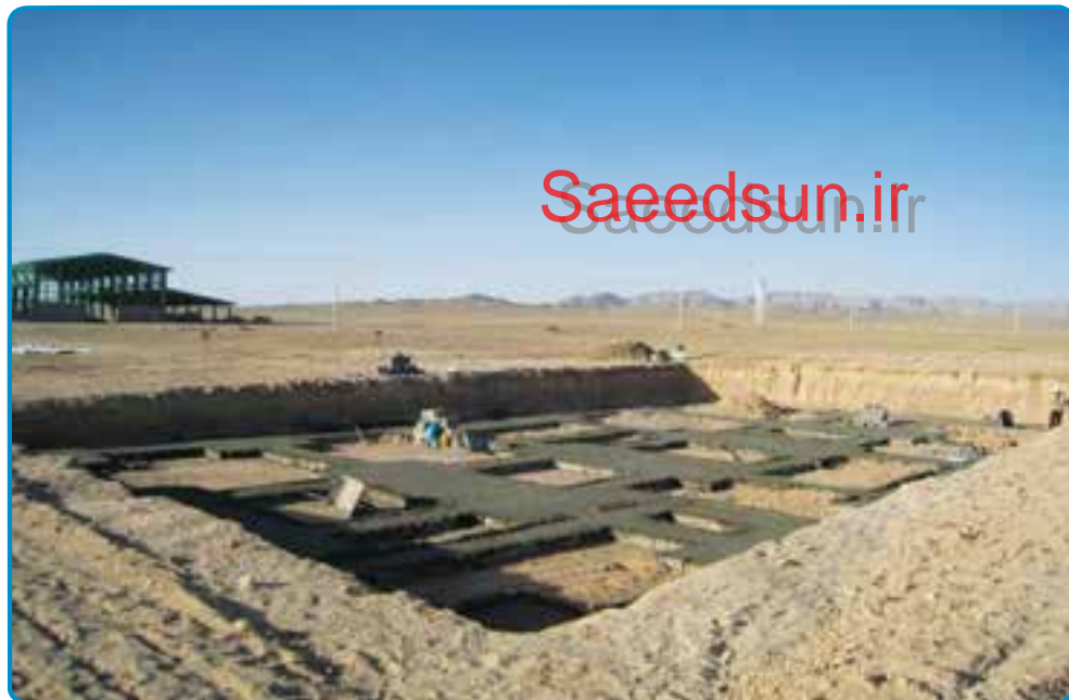
شکل ۳-۶- گودبرداری در زمین‌های نامحدود
