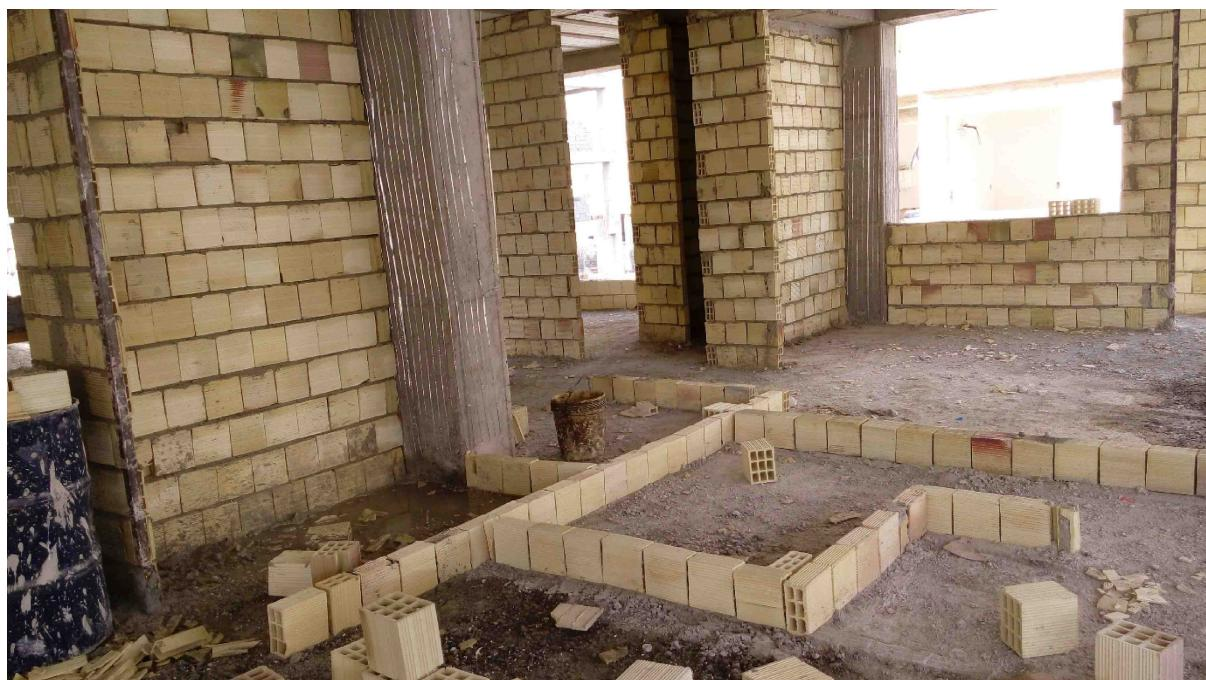
قبل از عمل سفت کاری ( سیمان پاشی یا شفته کاری (آستر ) ) کتیبه ها یا همان چارچوب های درها و لوله کشی ها و کانالهای برق کشی نیز انجام می شود و کف سازی هم اولیه صورت می گیرد .
