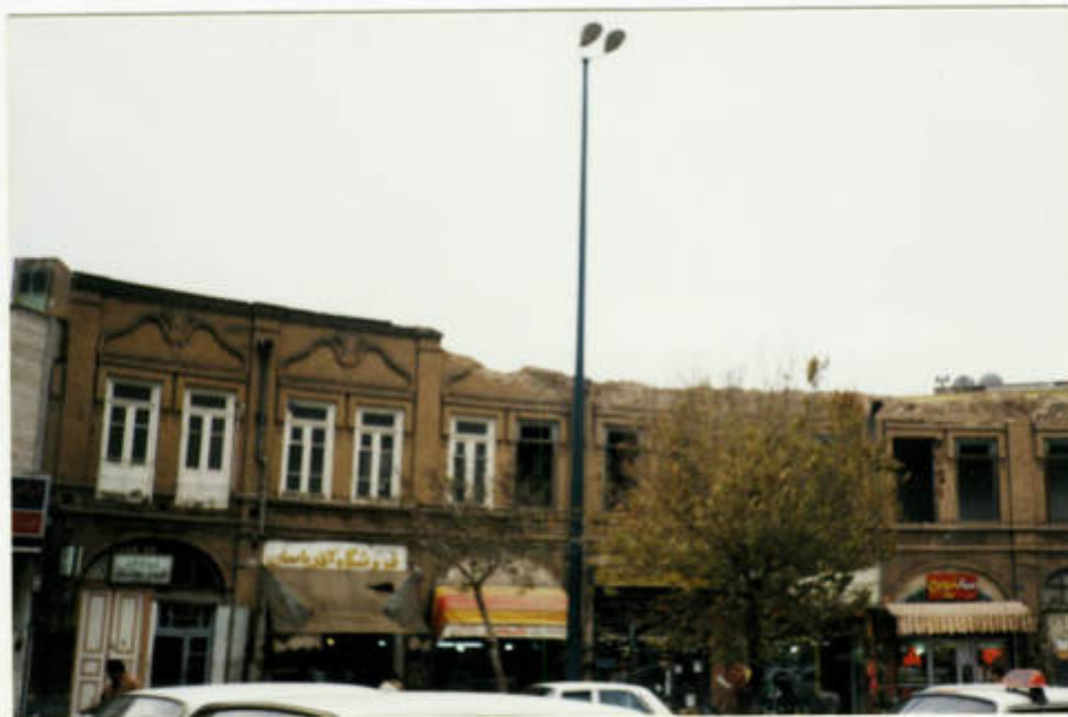
نمای محوطه بعد از تخریب
