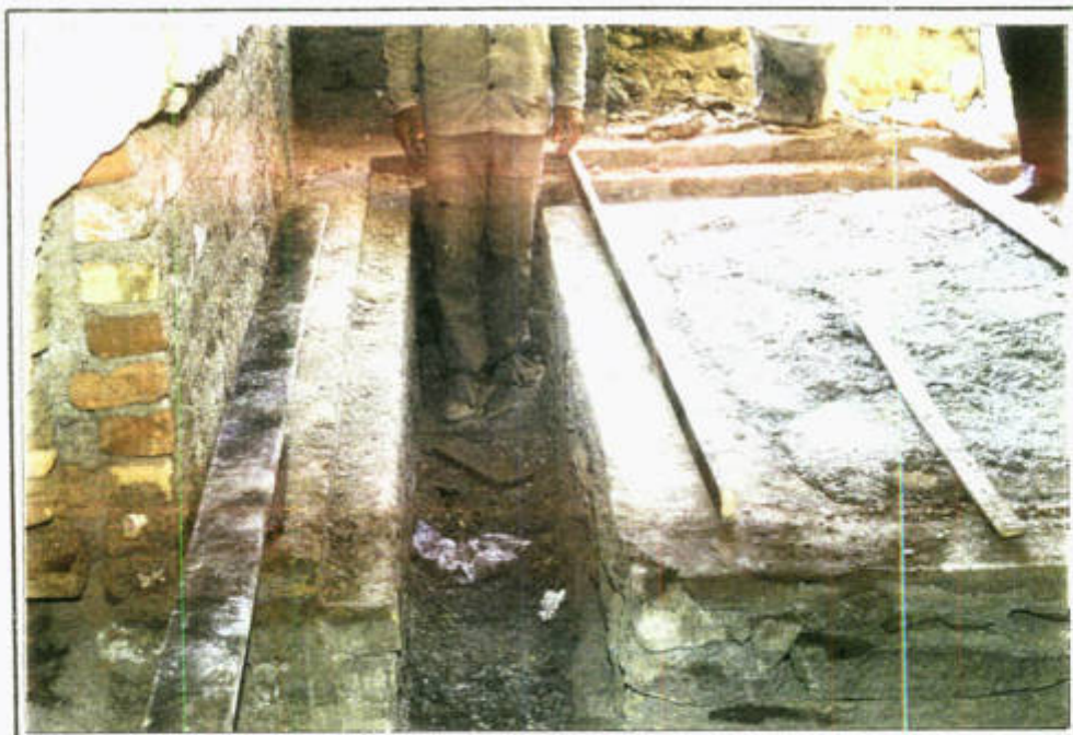
پوشش کانالها با درپوش بتنی و اجرای بلوکاژ و پوشش با بتن
