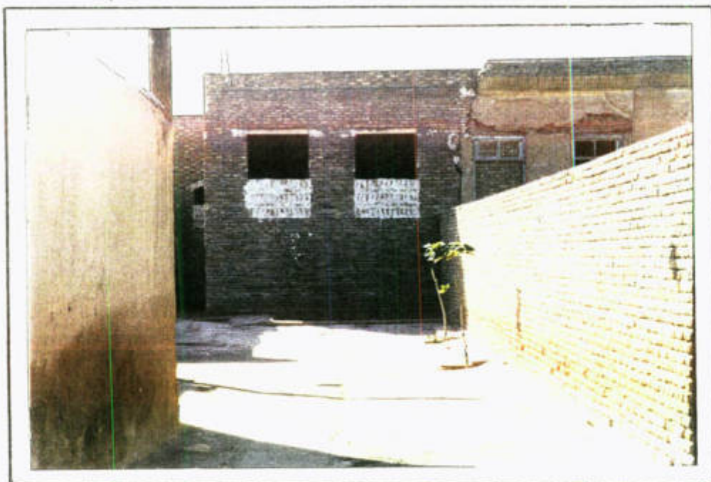
نمای بال شرقی بعد از مرمت و دوباره سازی
