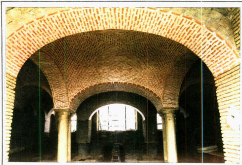
نمایی از بندکشی حوضخانه مرکزی
