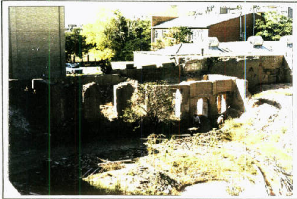
نمای ضلع غربی قبل از مرمت
