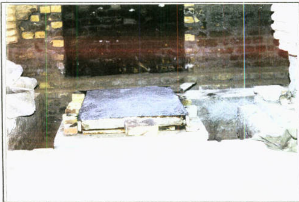
نمایی از اجرای کانال های نم زدا
