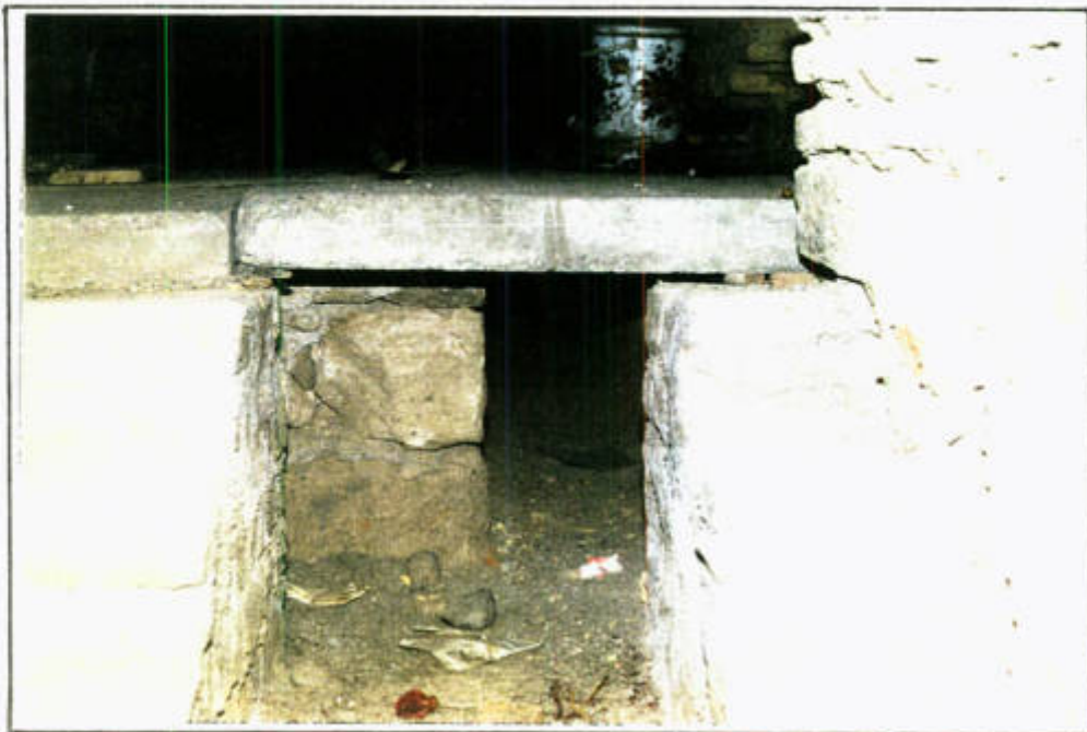
نمایی از کانالهای نم زدائی و درپوش بتنی
