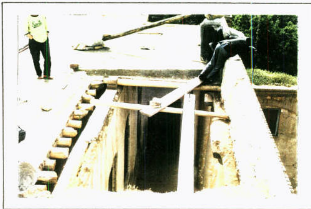
نمایی از مرمت پوشش سقف ایوان
