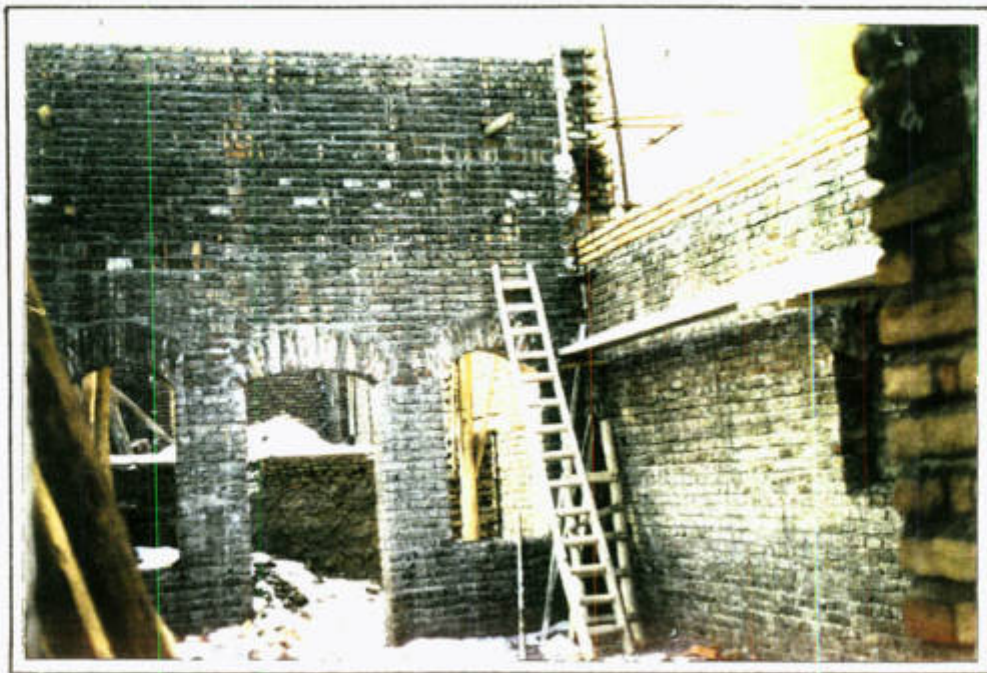
تخریب و دوباره سازی دیوارهای داخلی
