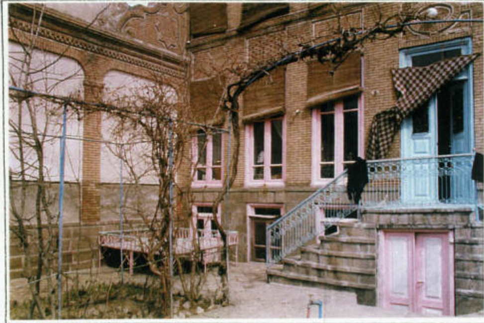
ساختمان غربی - نما
