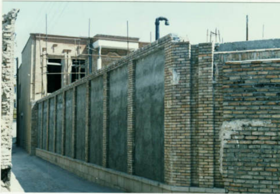
نمای جنوبی - (بوار غربی خانه)
