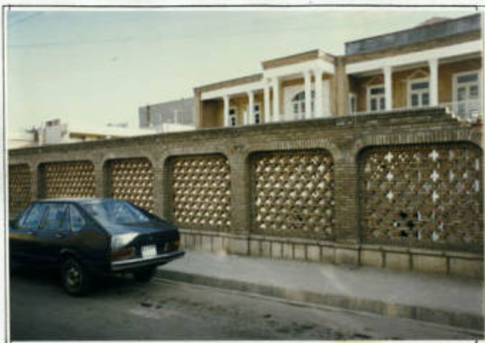
تعمیرات از مصالح خانه نقه ای از آناه صیفا ضلع تبریز
